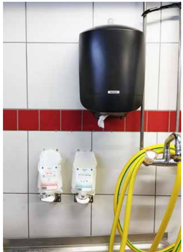
Nach der Montage
